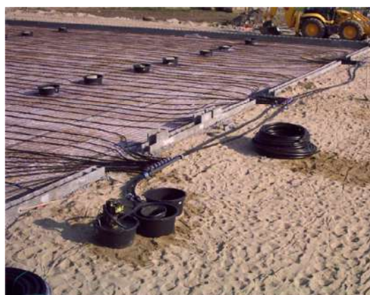
Photos des tuyaux avant le coulage du fond de fosse (Source SKOV)
