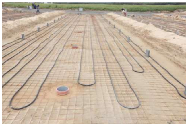
Photos des tuyaux avant le coulage du fond de fosse (Source SKOV)
